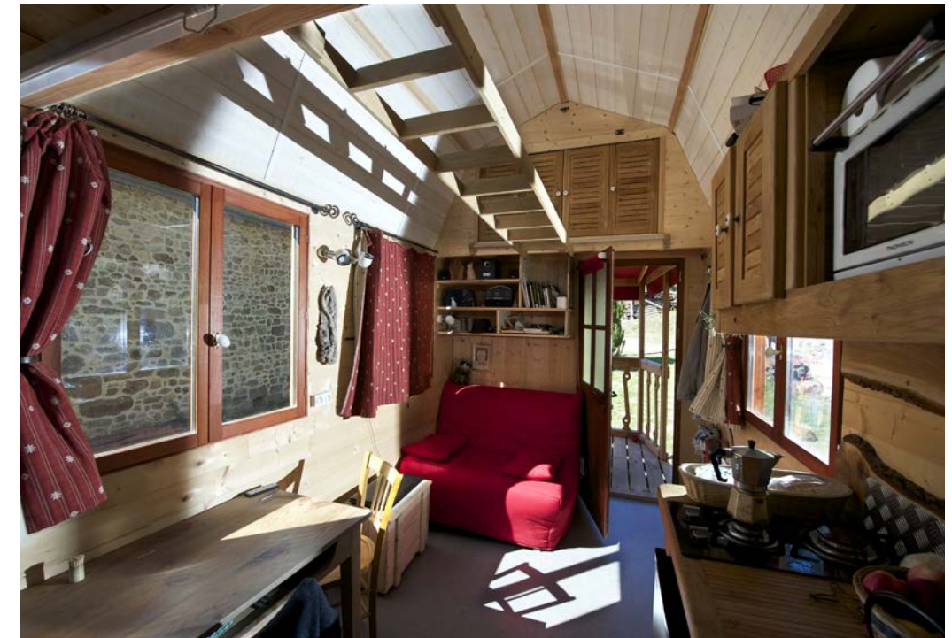
La hauteur entre plancher et plafond sous mezzanine est de 210 cm. 104 cm entre plancher mezzanine et dessous faîtière, ce qui laisse largement de quoi s'asseoir sur le matelas sans se raboter le crâne (même à deux).
